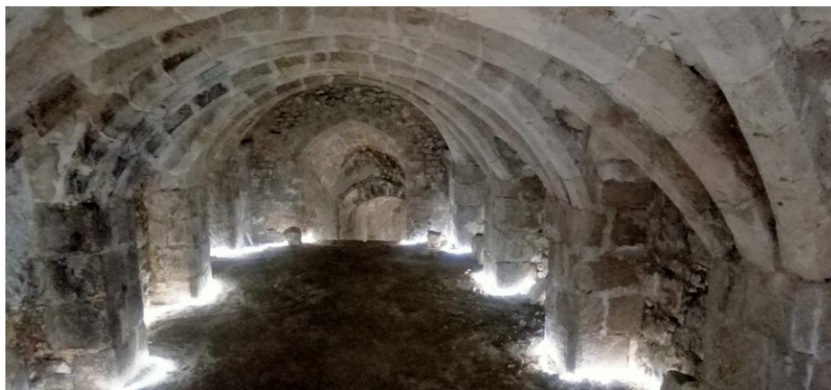
La cave médiévale de l'Ecole centrale
